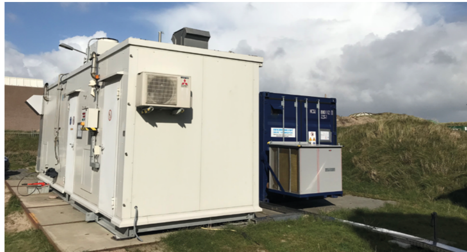
Voorbeeld van een Power-2-Heat pilot zoals momenteel opgesteld bij ECN in Petten.
